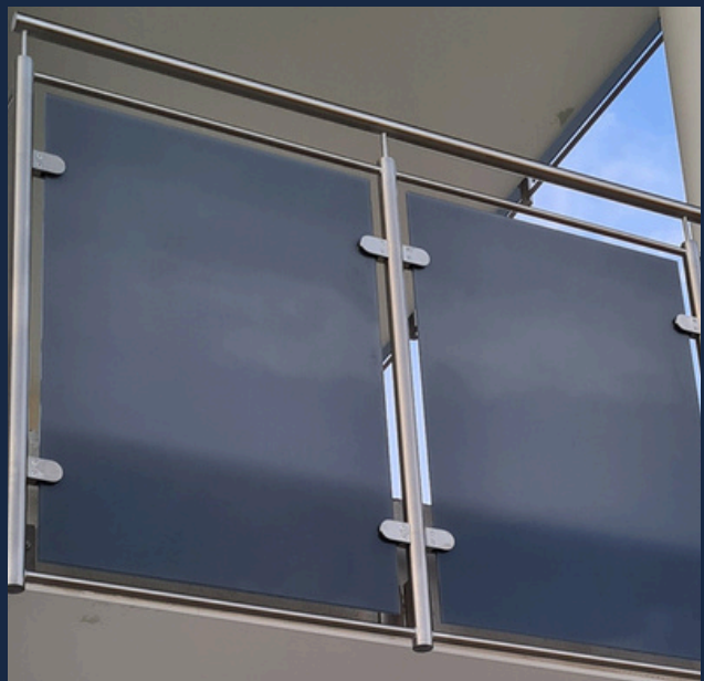
Geländer-Konstruktion aus Edelstahl - Geländerfüllung aus VSG grau
