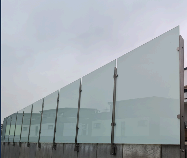
Unterkonstruktion in Edelstahl - Doppelpfosten aus Flachstahl - Geländer- füllung aus VSG matt
