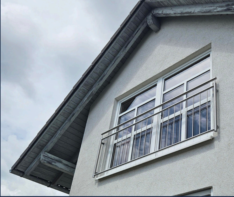
Edelstahl - Rahmen, Handlauf sowie senkrechte Stabfüllung aus Rundrohren
