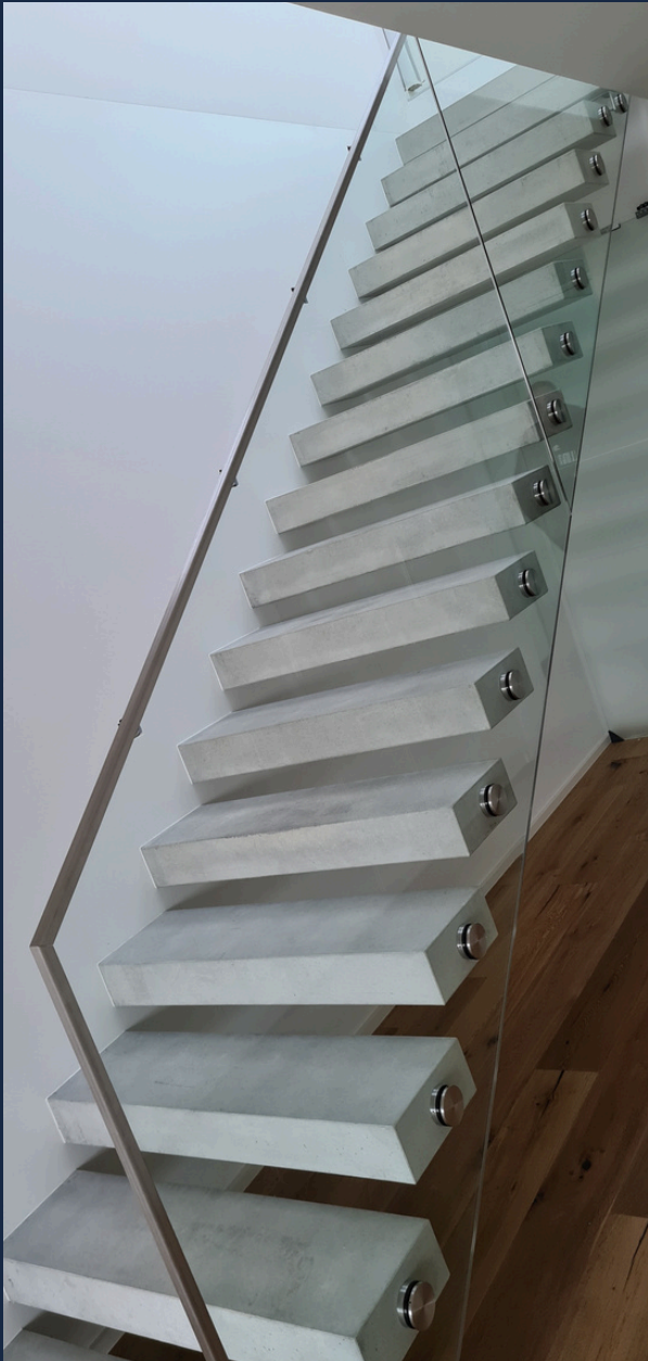
Glasgeländer mit Punktbefestigung - VSG klar - inkl. Glaskantenschutz
