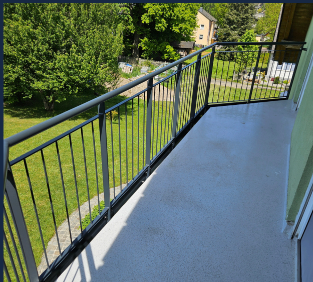
Stahl pulverbeschichtet - Pfosten aus Flachstahl - senkrechte Stabfüllung aus Rundstab - Handlauf aus Rundrohr
