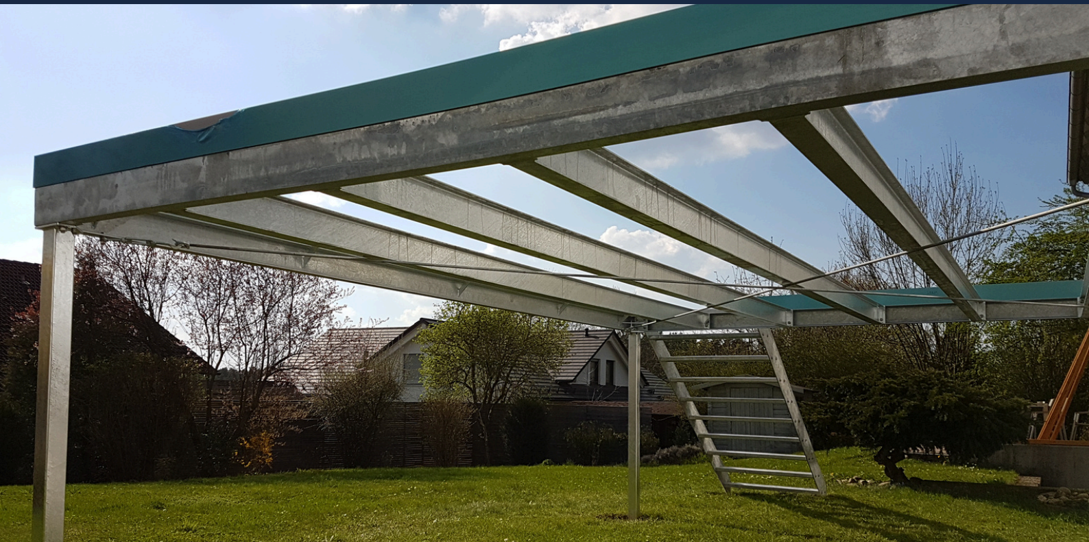
Unterkonstruktion in Stahl feuerverzinkt
