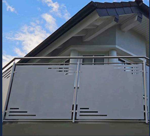
Unterkonstruktion in Edelstahl - Geländerfüllung als Blechfüllung in RAL9006, Muster nach Kundenwunsch
