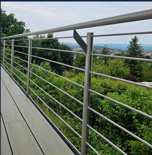
Geländer aus Edelstahl - waagerechte Stabfüllung - Handlauf nach innen gesetzt
