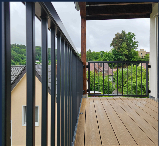
Stahl pulverbeschichtet in RAL7016 - Rahmen sowie senkrechte Stabfüllung aus Vierkantrohr -zus. U-Schiene als Handlaufabschluss
