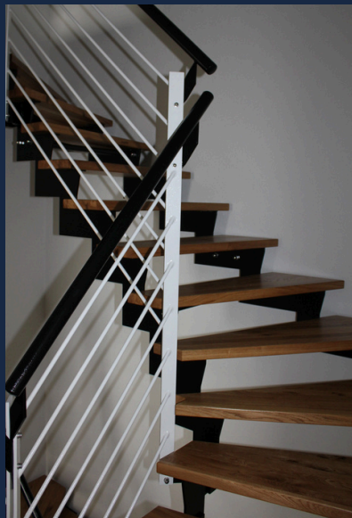
Holmtreppen - Holme pulverbeschichtet waagr. Geländer pulverbeschichtet (li) und Ganzg-lasgeländer (re) Stufen aus Buche (li) und Eiche (re)
