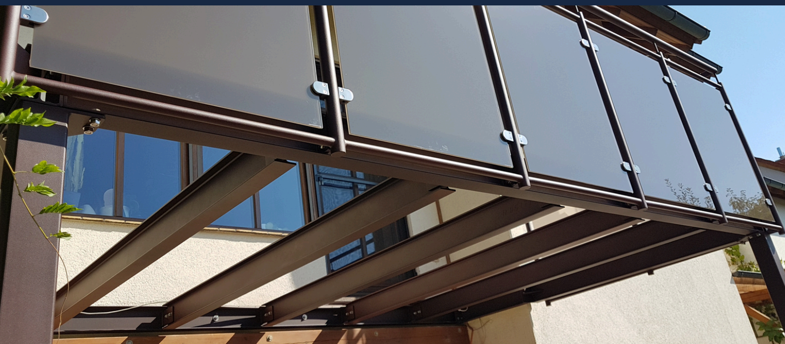
Unterkonstruktion in Stahl pulverbeschichtet
